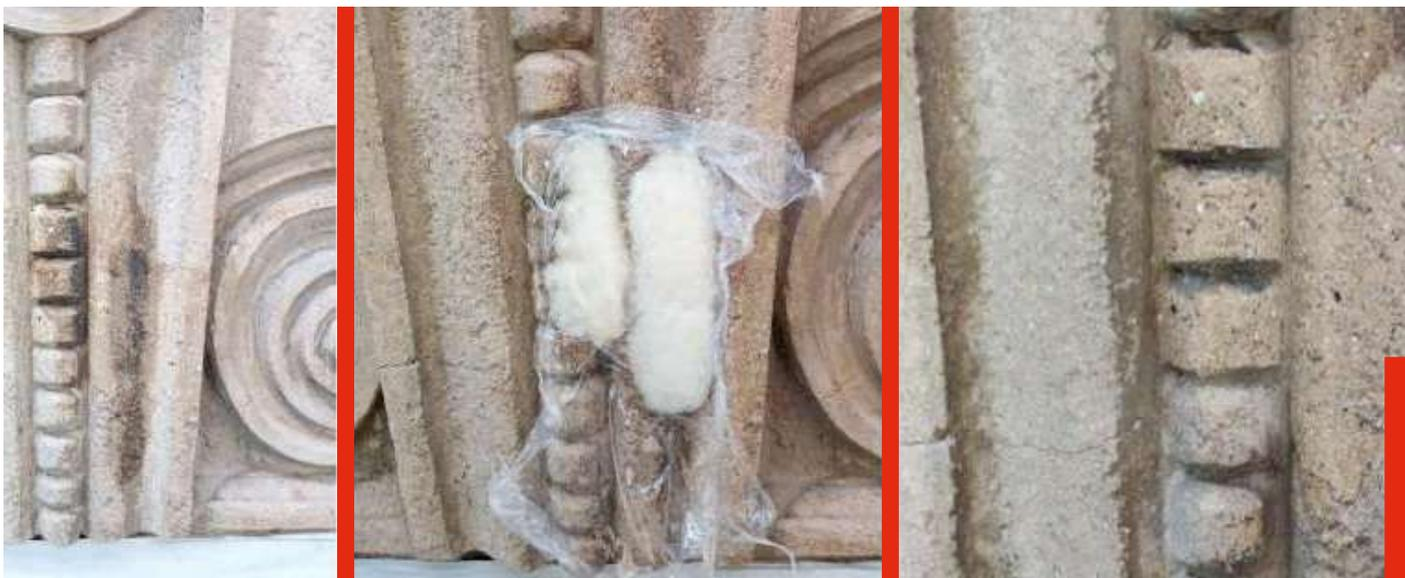
Impacco con AB57 per la rimozione delle croste nere
