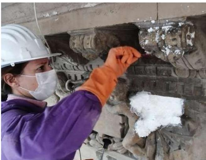
Per la rimozione delle croste nere sono stati eseguiti numerosi impacchi imbibendo la polpa carta con una soluzione di carbonato d'ammonio e sali di E.D.T.A. bisodico con tempi di contatto di un'ora e mezza circa.
