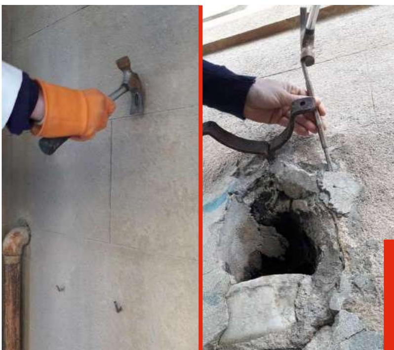
Rimozione dei chiodi e delle stuccature in cemento
